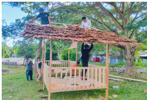
Gambar 5. Pemasangan Atap Gazebo.
