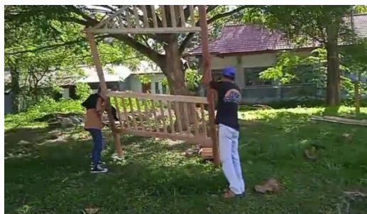
Gambar 3. Pemasangan Patok Gazebo.
